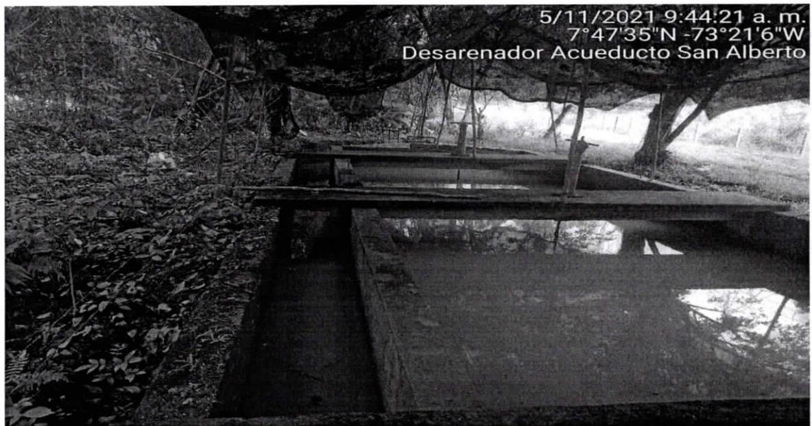
**Figura 4.** Desarenador EMPOSANAL S.A E.S.P.
