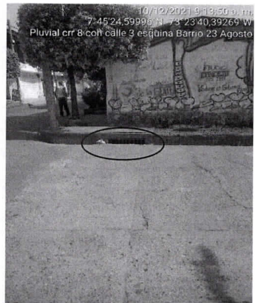
Figura 8. Alcantarillado Pluvial Crr 8 con calle 3 esquina, barrio 23 de Agosto.
