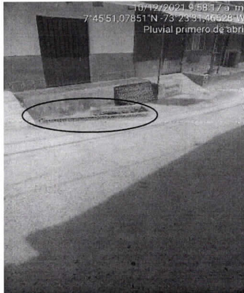
Figura 5. Alcantarillado Pluvial Carrera 1D Barrio Primero de Abril
